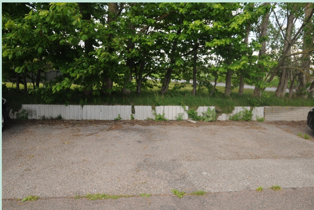
BILLEDE 3 ALTERNATIV ANVENDELSE AF ETERNITPLADER TIL AFGRÆNSNING AF TERRÆNSPRING VED P-PLADSER
