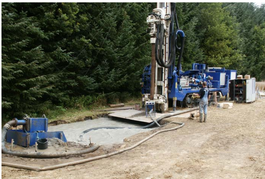
Figur 2.3. Indretning af boreplads ved skylleboring med lufthæve-metoden.
