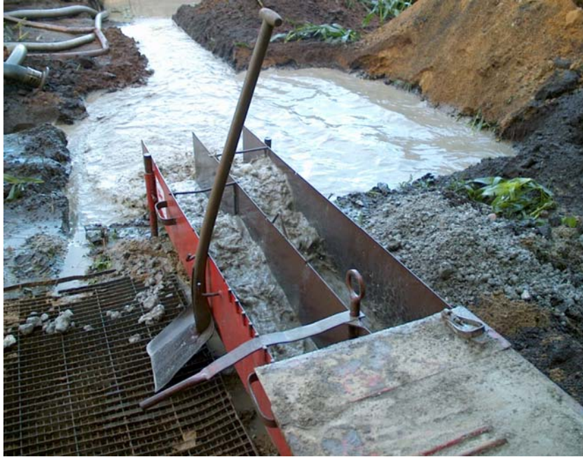
Figur 2.6. Sedimentfang med to sliske og overløb. Passagen til sliskerne kan indstilles, så strømmen af boremud- der herigennem bliver begrænset.
