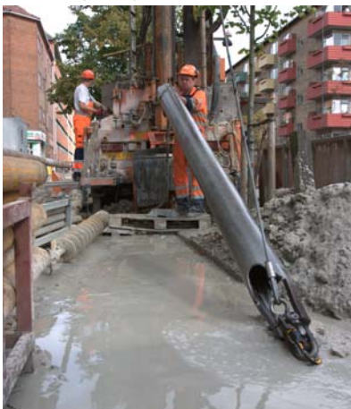
Figur 2.1a Tømning af sandspand. Foto: Jens Baumann, GEO.
