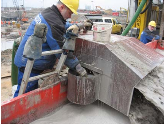
Figur 2.5c. Udtagning af prøve i sedimentfang med tragt.
